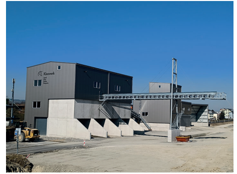
Aushubwaschanlage Kieswerk Ballwil
